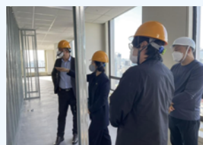
기관장 주관 시설 안전 현장 점검
